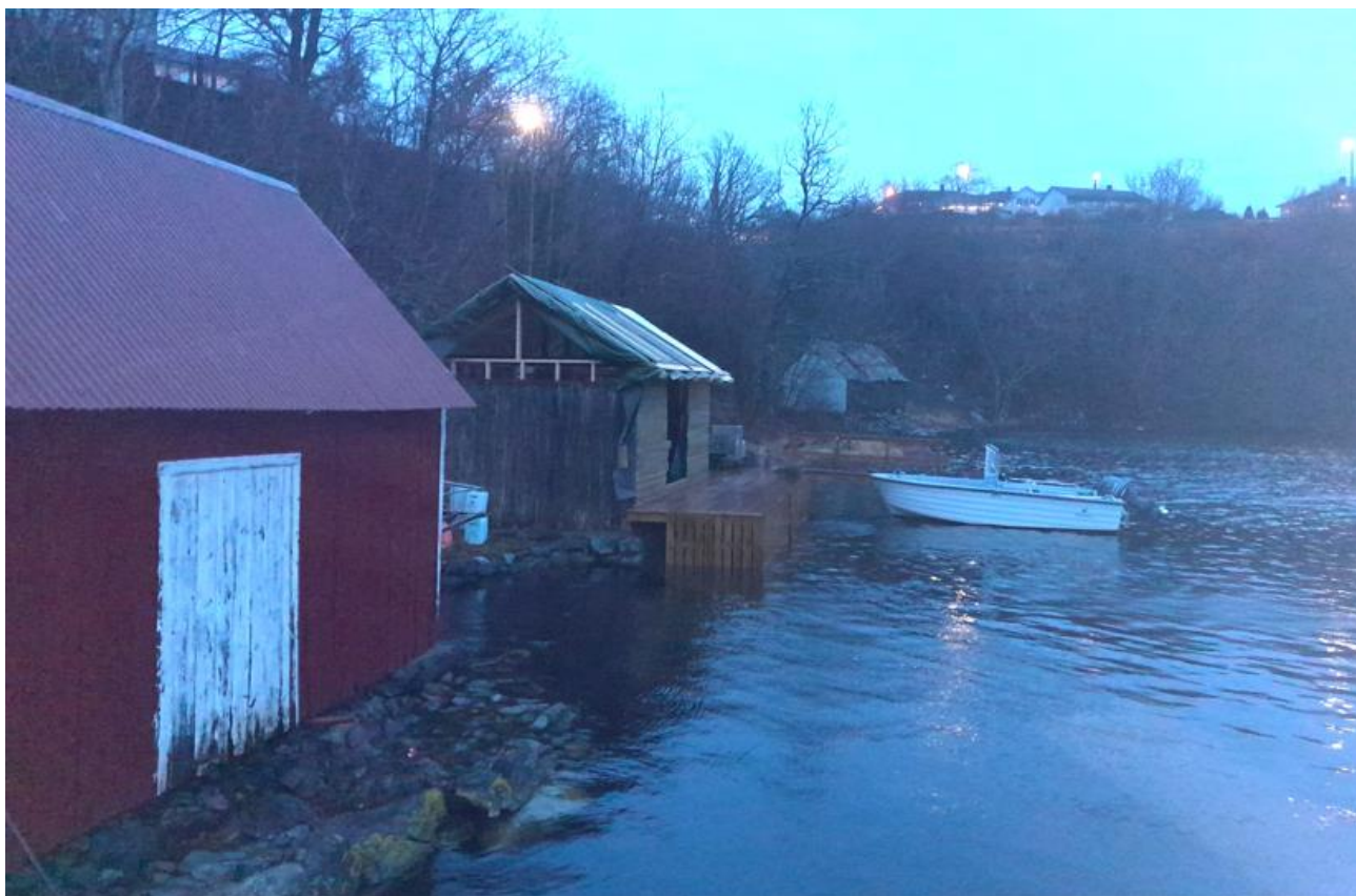
Bildet viser naustet innafor planområdet til venstre, deretter nabonaust under rehabilitering (ikkje omfatta av plan).
