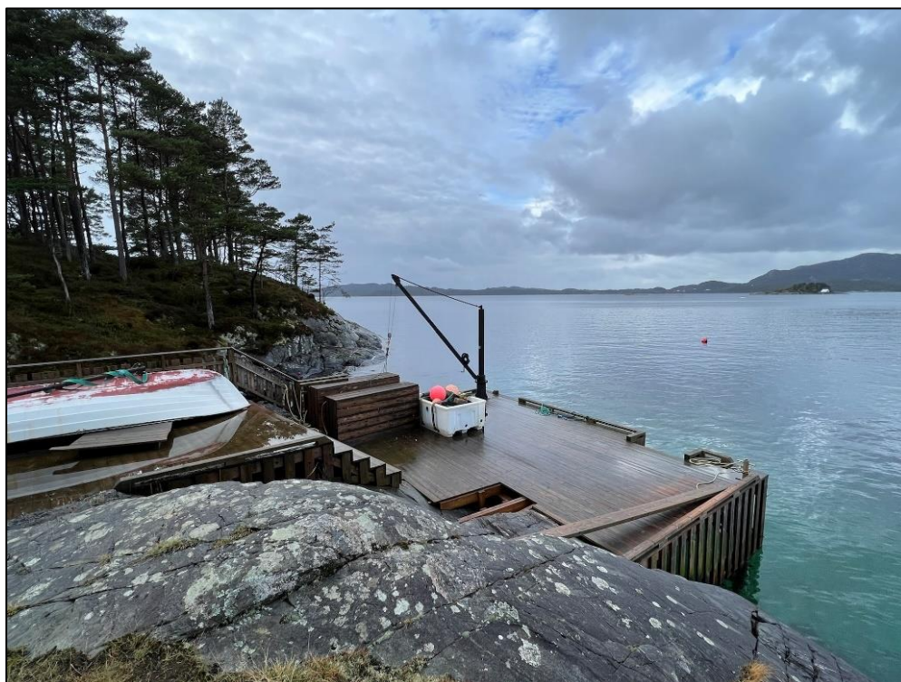
Eksisterande kai innanfor planområdet. Kaien vart bygd i 2014.
