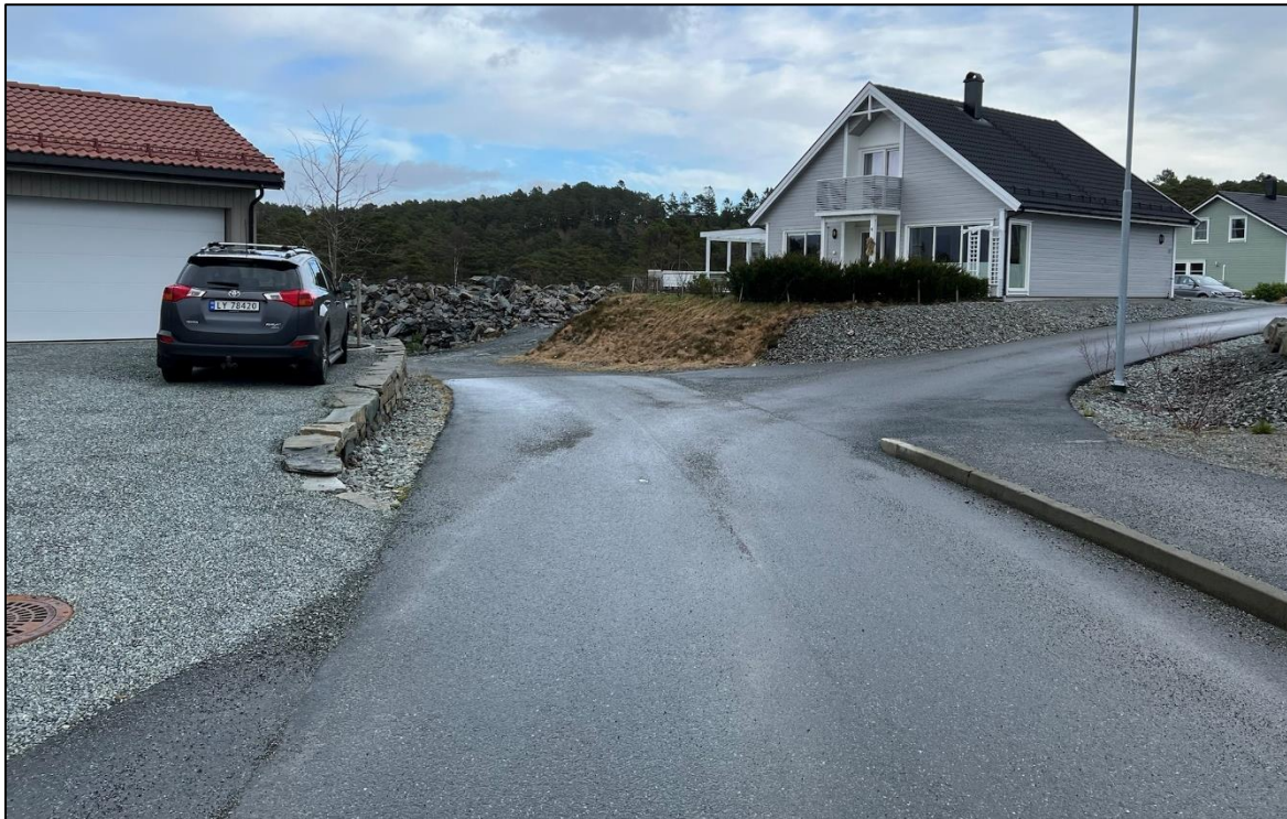
Eksisterande køyreveg med fortau som går fram til planområdet i dag. Vegen er asfaltert fram til eksisterande bustad på 14/279.
