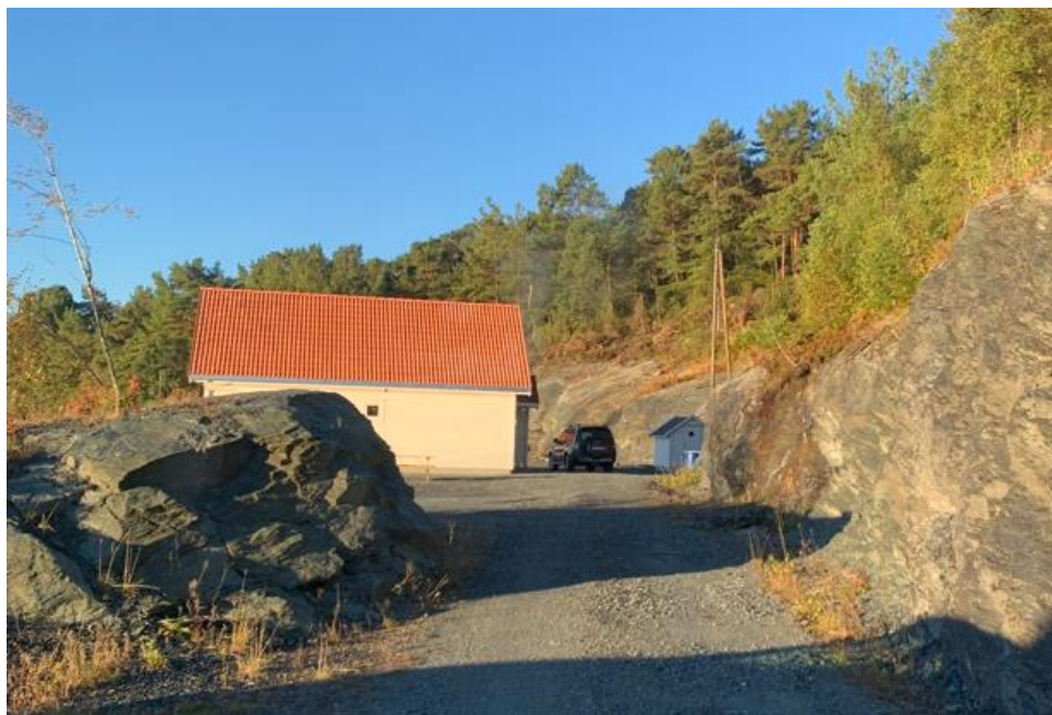
Figur 46 Bilete som syner situasjonen i sør, med skjeringa i bakkant av naust
