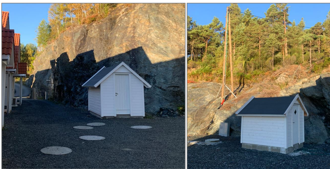
Figur 34 Pumpehus ved VA1 og VA2
