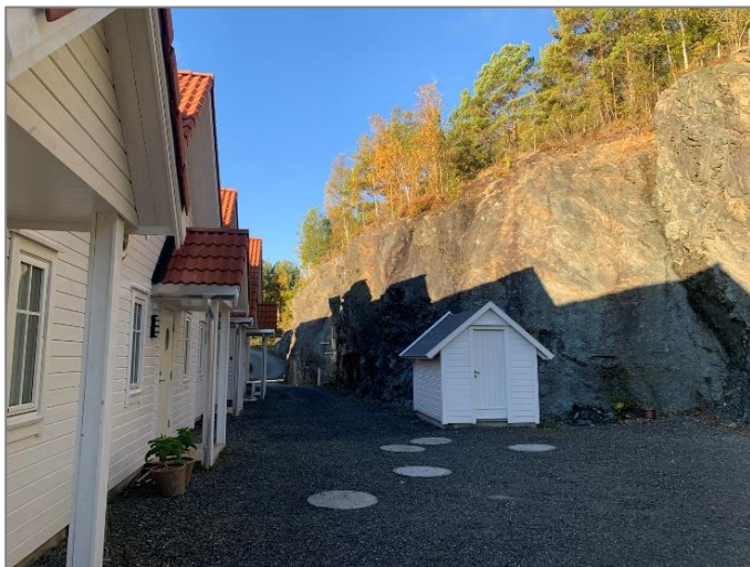
Figur 48 Bilete som syner veg, skjering og pumpehus i bakkant av UNB1-2
