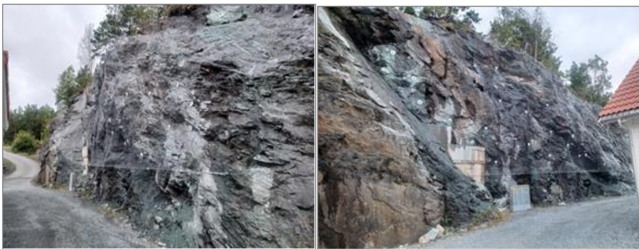
Figur 49 Bilete som syner utført sikringsarbeid i bakkant av UNB1-2
