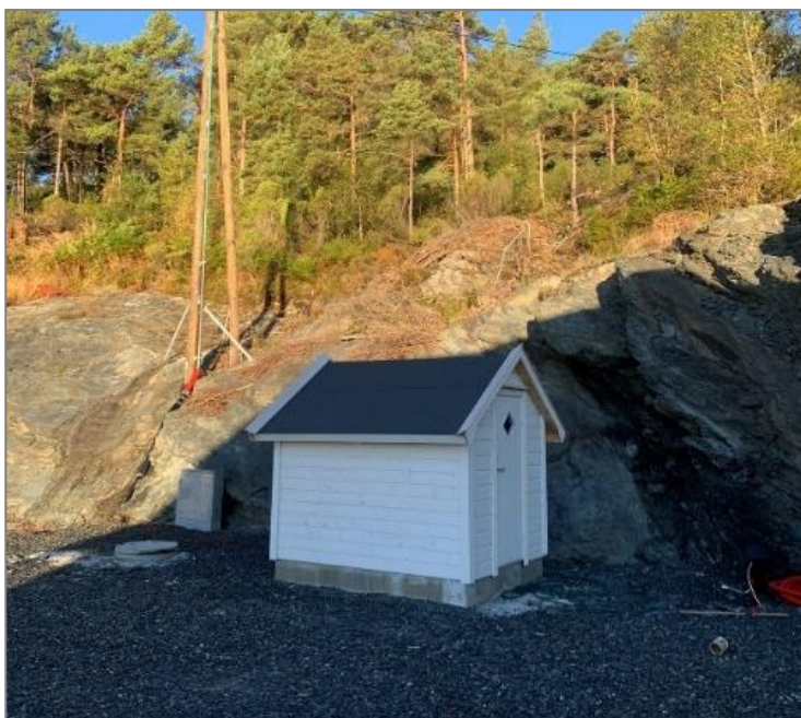
Figur 23: Bilete som syner pumpehus, slamavskiljar og straumskap.
