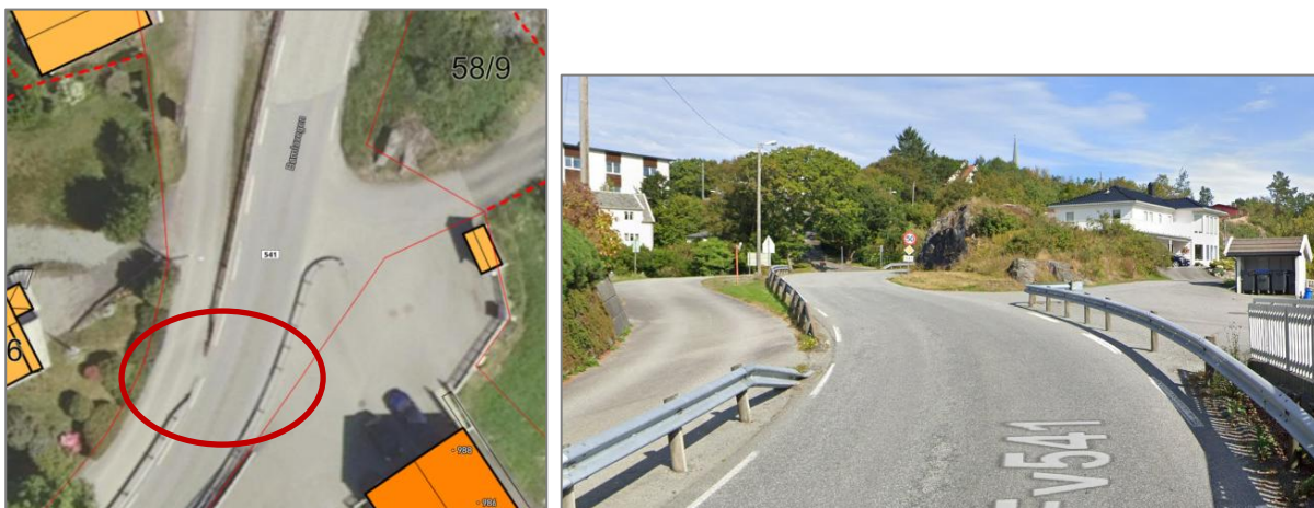
Figur 19 utsnitt som syner opning i rekkverk
