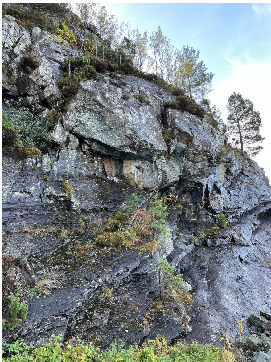
Figur 8: Samme skrent som i Figur 7, men tatt med kamera fra bakkenivå. Bildet viser blokker uten fot.
