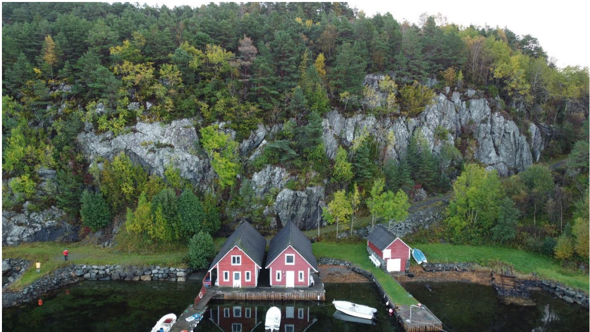
Figur 9: Skrenten direkte bak de eksisterende naustene har delvis avløste blokker. Til venstre for naustene er det ur nedenfor skrenten, og blokker vil enten stoppe i ura (1/100) eller nå ut på vegen (1/1000). Skrenten bak naustene er nær-vertikal og vi vurderer at blokker vil falle rett ned på den flate vegen mellom naustene og skrenten.
