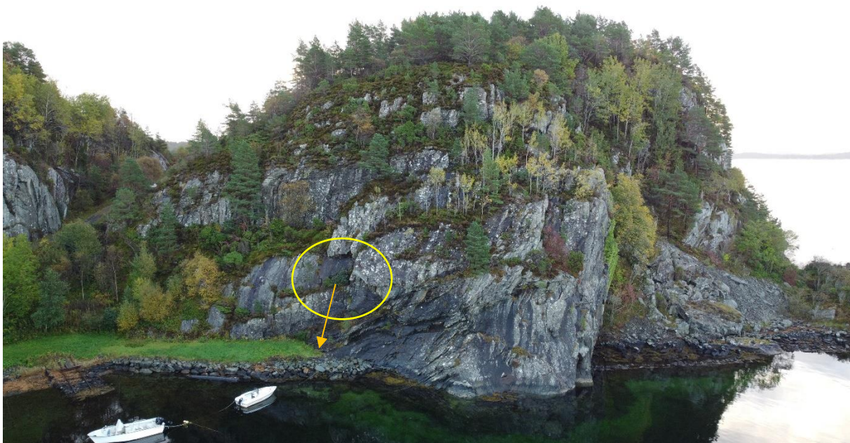
Figur 7: Sørliche del av naustområdet. Deler av berget har ikke fast fot, og det er flere delvis avløste blokker. Gul ring viser blokker uten fot. Vi vurderer derfor årlig sannsynlighet for steinsprang som større enn 1/100. Bildet er tatt med drone.
