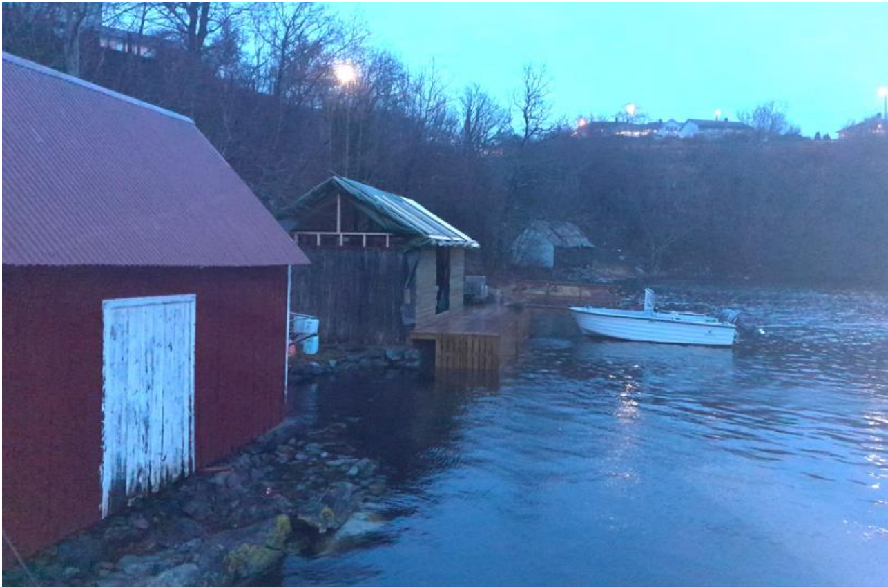
Bildet viser naustet innafor planområdet til venstre, deretter naust under rehabilitering, og deretter naust som står til nedfalls.
