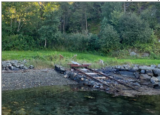
Figur 34: Eksisterande båtopptrekk/slipp innanfor SMS2.
