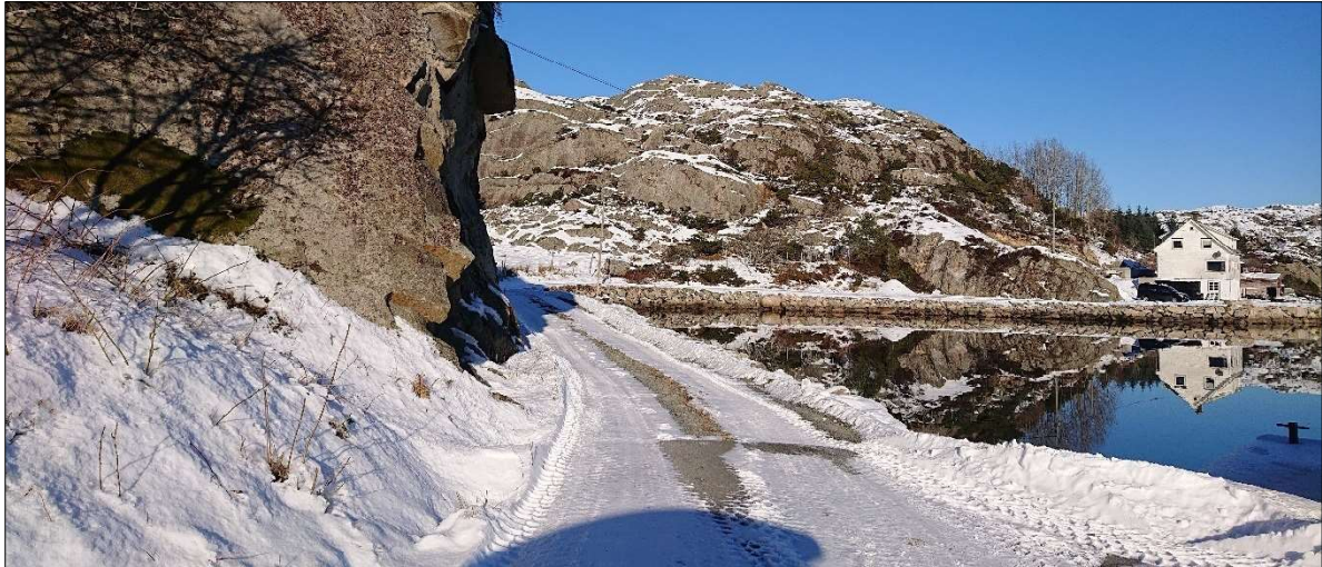
Pv1195 som inngår i planområdet, sett frå overgang ved Kv1195, mot nord-aust.
