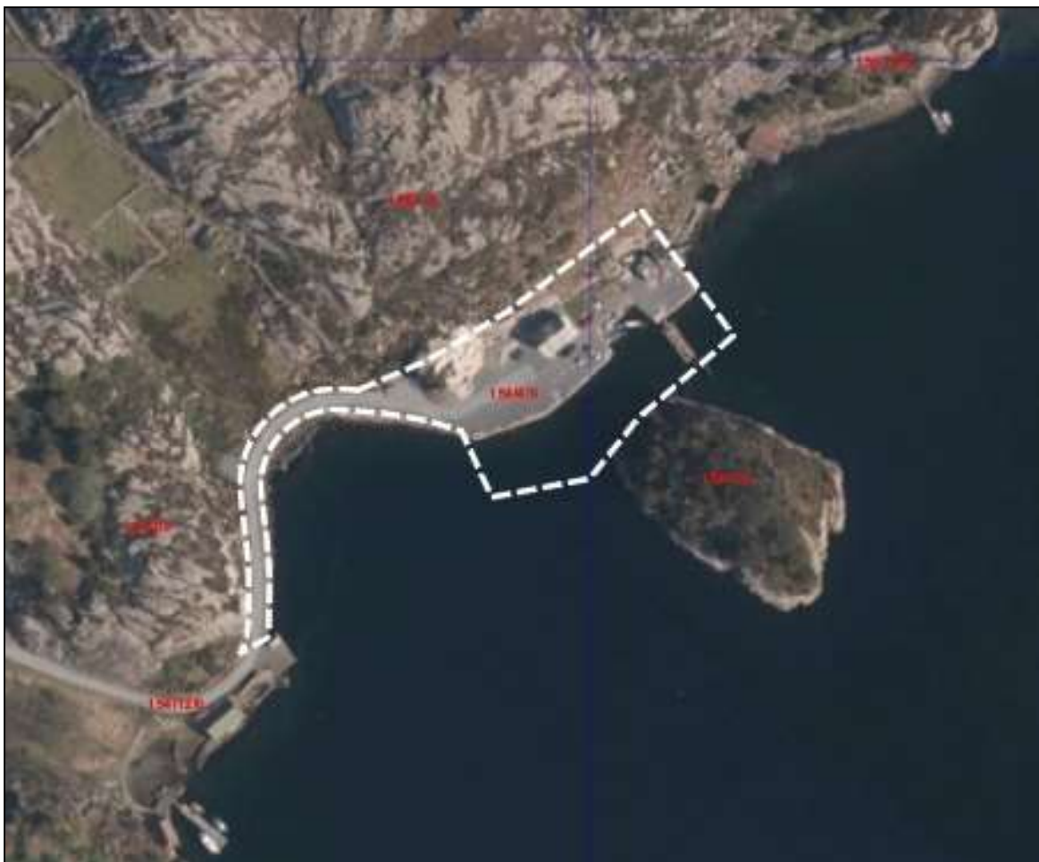
Flyfoto med plangrense som syner tekniske inngrep i området.
