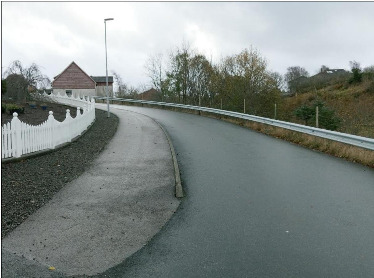
Vegen til Stavelandsneset i dag. Ca 4,5m asfaltert veg og ca. 2,0m asfaltert fortau på den eine sida.
