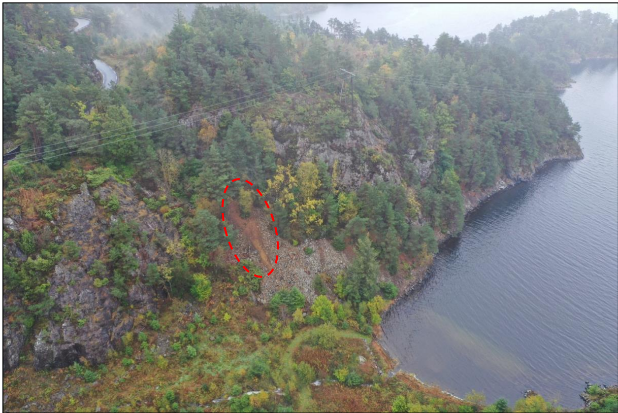
Figur 5: En mindre jordskredhendelse kan sees i øvre del av en ur i skråningen øst for Hetlevika. Dronebilde tatt mot sørøst.
