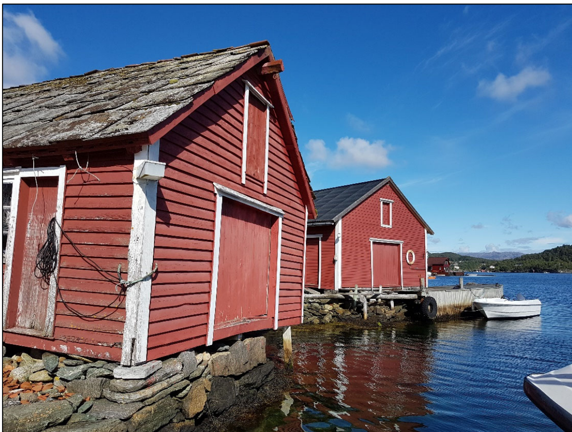
Eksisterande naust på 8/54 og 8/41. Begge er planlagt å rive.
