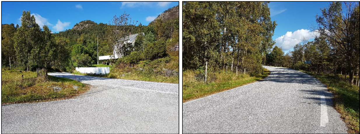
Bileta viser sikt i eksisterande kryss inn mot fylkesvegen.
