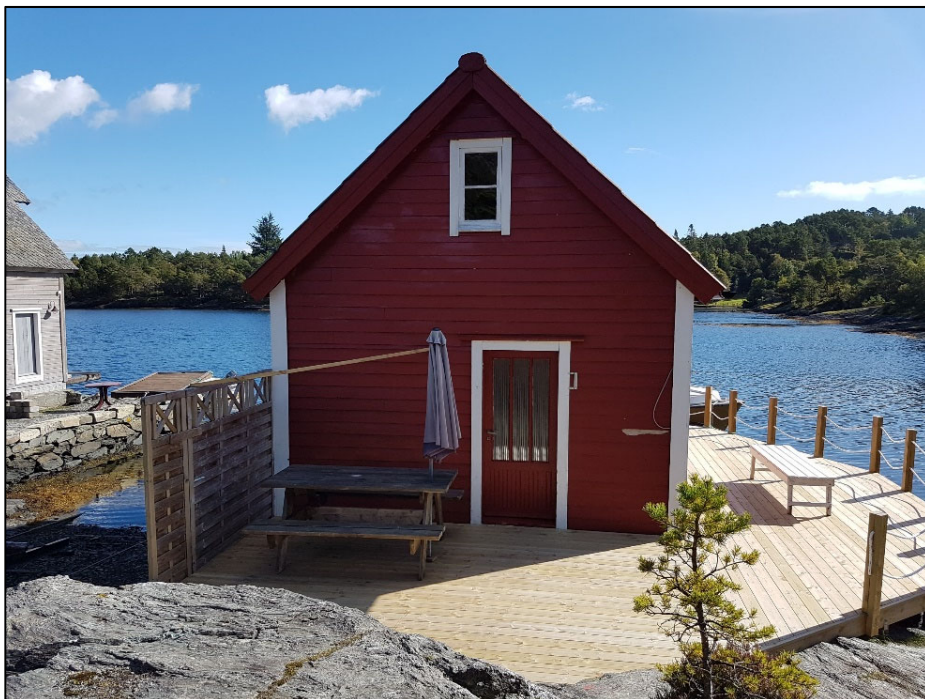
Eksisterende naust og kai på 8/40.
