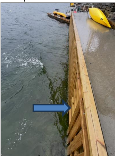
Figur 1: Bilete som viser trefronten på eksisterande kai med innfelte trinn.
