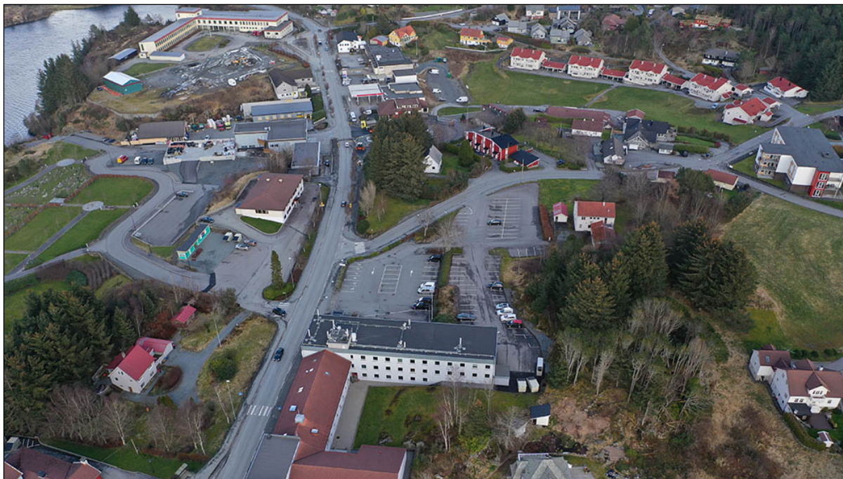
Ny brannstasjon er skal byggjast på tomte der gamle prestebustaden står i dag – til høgre på bilete. (Foto: Geir Einarsen)
