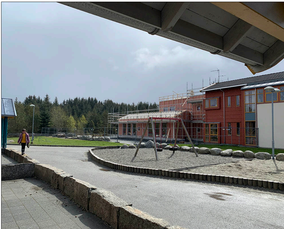
Ny personalfløy ved Svortland skule aukar bygningsmassen å vedlikehalda.
