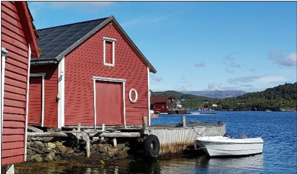
Bilete syner dagens situasjon på eigedom 8/41, med naust og kaianlegg, sett mot nord.
