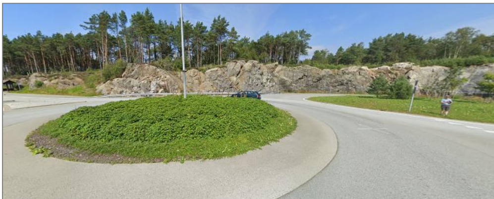
Figur 32: Eksisterande rundkøyring ved Hollundsdalen. Google maps.
