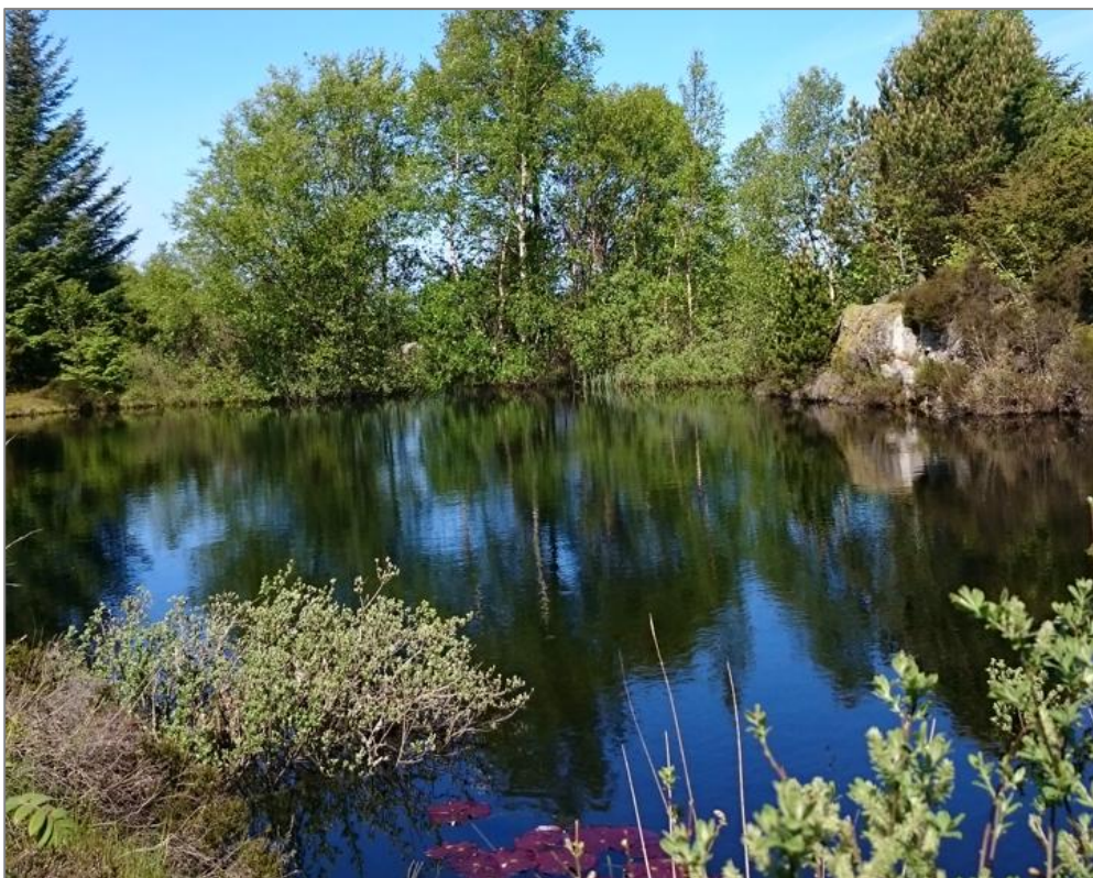
Figur 12: Bilete av dam D2.
