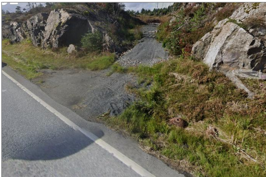
Figur 67: Eksisterande sandfang, Pkt. 5.
