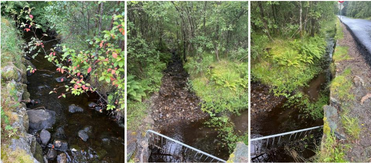
Figur 4-36. Nedstrøms kulvert under Stokkabekkveien, el-fiskestasjon Fold2 t.v. Oppstrøms kulvert: naturlig bekkeløp i midten, stående vann i grøft langs veien t.h.
