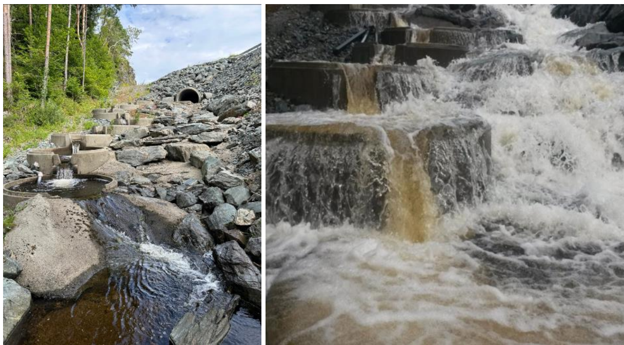
Figur 4-7 Fisketrappa under lav og høy vannføring, bildet t.v er tatt under befaring og t.h er hentet fra vestlandfylke.no. (Foto: Jarle Martinsen)
