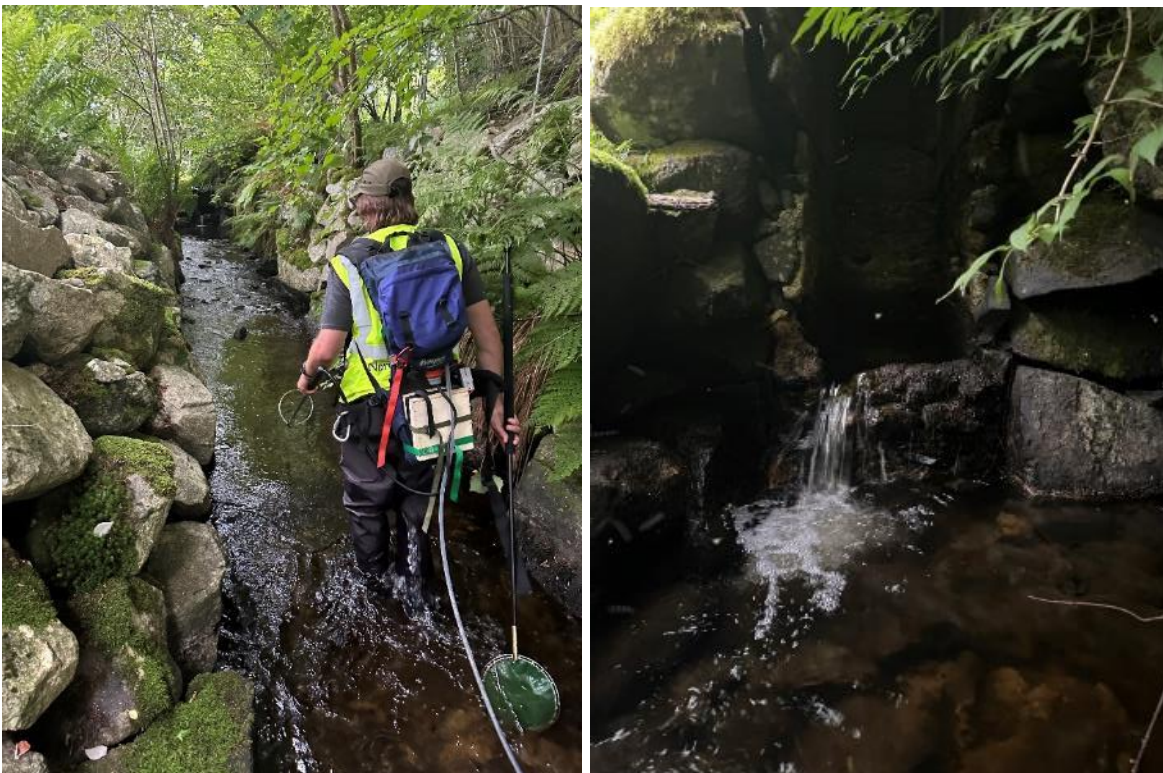
Figur 4-78. T.v.: Forbygning og kanalisering i segment 8. T.h.: utløp fra Selsvatnet gjennom terskel med bunnåpning øverst i segment 8..
