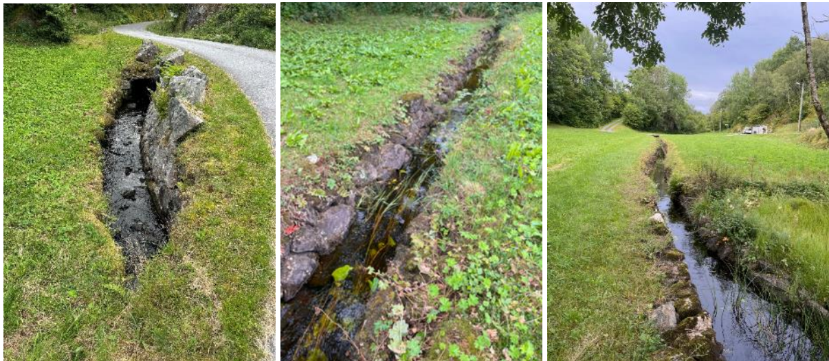
Figur 4-34. Kulverter under Hamnavegen like ovenfor utløp til sjøen t.v. Kanalisert bekkeløp med lav habitatkvalitet gjennom jorde, nedre del i midten og øvre del t.h.
