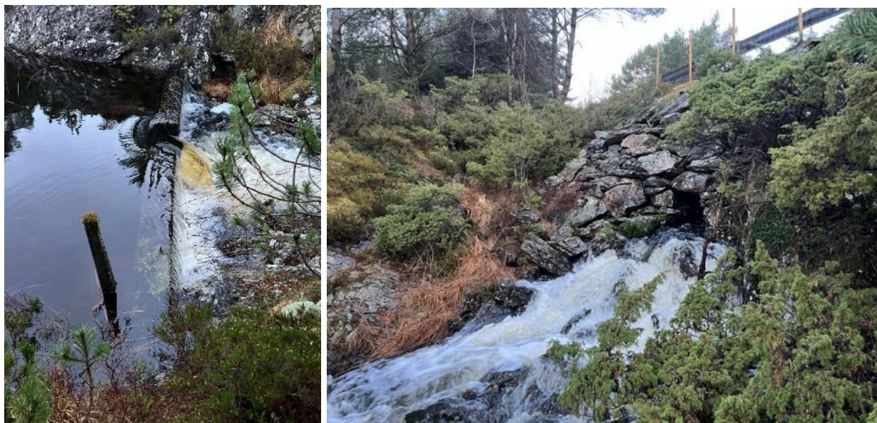
Figur 4-28. Demning i Tjongevatnet og kulvert under Vikavegen ved høyere vannføring enn på befaringstidspunktet.
