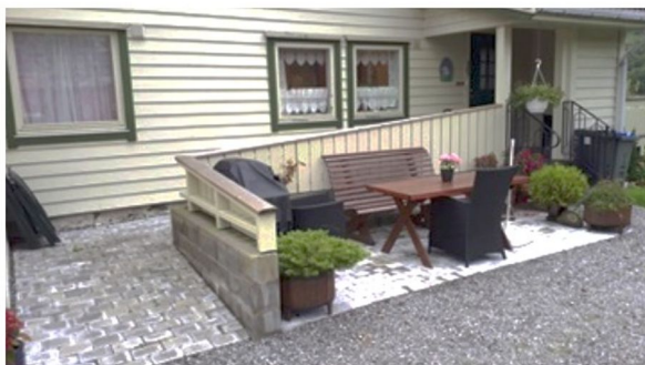
Etter utbetring – trinnfri tilkomst, fast dekke, samt ein flott sitteplass! Dette gir ein reell oppgradering av tomta.
