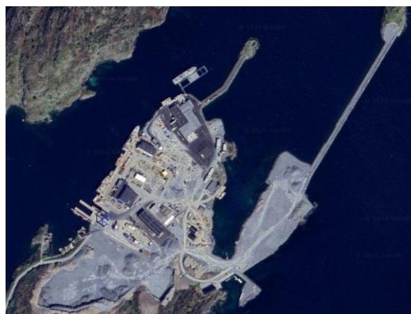
Figur 4-10 Dagens situasjon (google.com/maps 2026)
