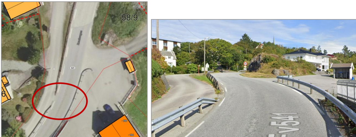
Figur 19 utsnitt som syner opning i rekkverk
