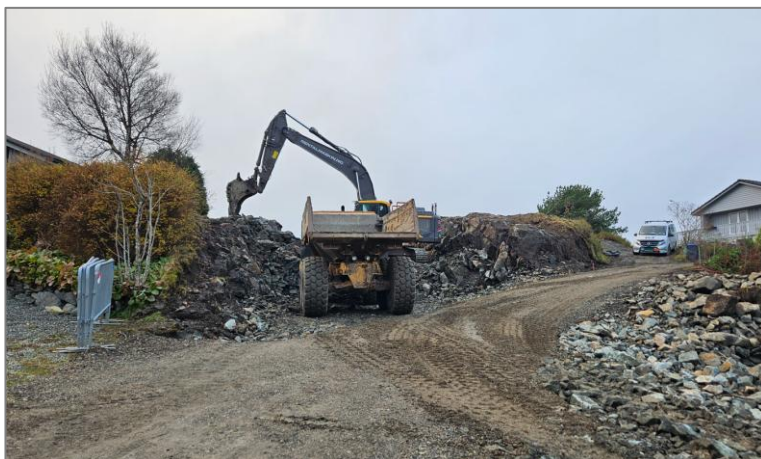
Figur 6: Til venstre i biletet ser ein hekk og hage til gbnr. 108/100 og til høgre for gravemaskina ser ein knausen som no vert noko redusert (LF6). Det var på dette stadiet at ein såg at delar av hagen ville forsvinne dersom ein skal sprengje seg ned her.
