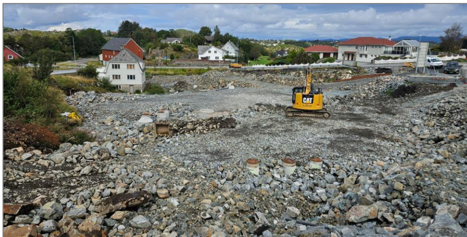
Figur 14: Bilete som syner masseutskiftinga for o_SKV3 og BKS1. Her var det ei djup holde som no er masseutskifta.
